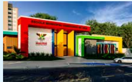
ESCOLA MUNICIPAL COMEÇINHO DE VIDA. Trata-se de uma das mais tradicionais escolas públicas da cidade. O prédio está em obras no Setor Nossa Senhora de Fátima, próximo ao Fórum.
