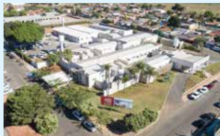
HOSPITAL MUNICIPAL E MATERNIDADE DR. EVARISTO VILELA MACHADO. Estrutura foi ampliada e saltará de 20 para 45 leitos de enfermaria. Hospital também ganhará 10 novos leitos de UTI.
